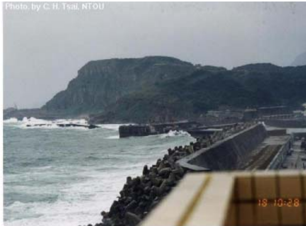
圖 2 東北季風的湧浪強勁時八斗子碧砂漁港防波堤外之波浪，其水面已衝上防波堤前之平台
